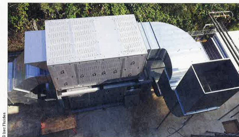
Deux récupérateurs d'énergie sur l'air extrait ont été mis en œuvre dans la cuisine centrale du Mans (72).
